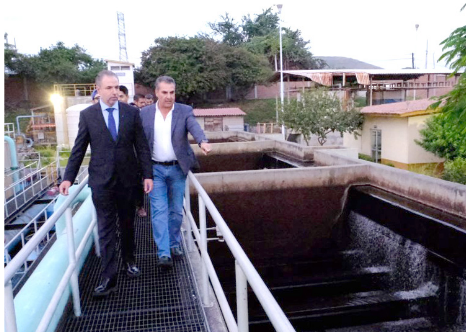
La infraestructura potabiliza actualmente 200 litros de agua por segundo.
