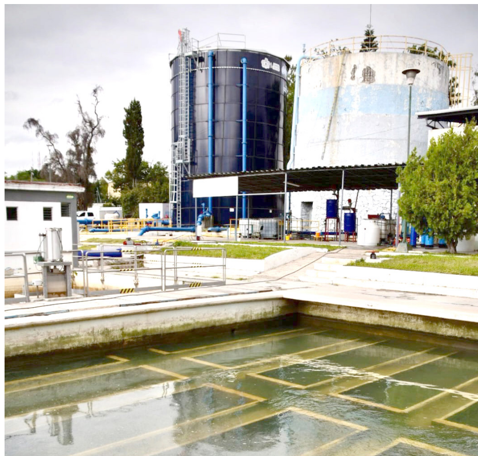
La Planta Potabilizadora Número 1 de Miravalle.
