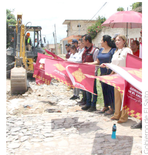
Nena Farías, dio el banderazo de arranque de las obras.
