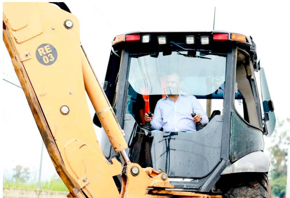
Las obras beneficiarán a las y los habitantes de Rancho Alegre, Los Silos y Los Agaves.
