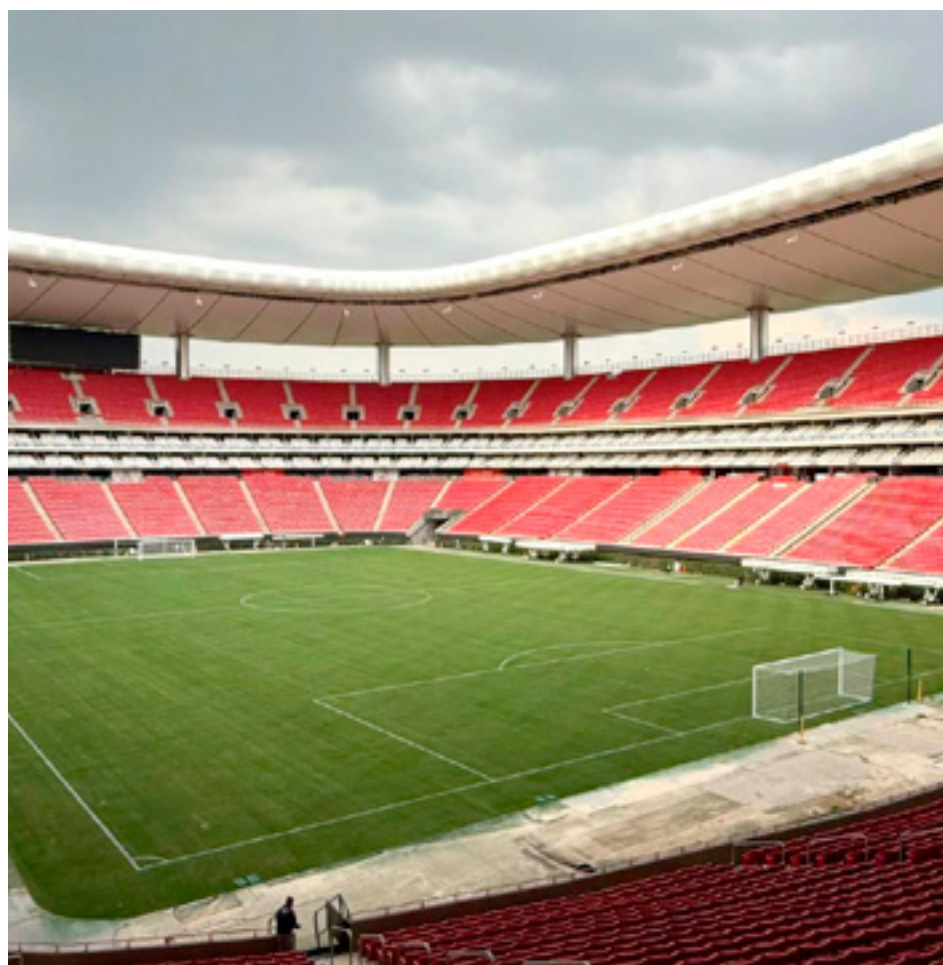
El sistema de riego y drenaje fue cambiado, además de colocar nuevo pasto.
