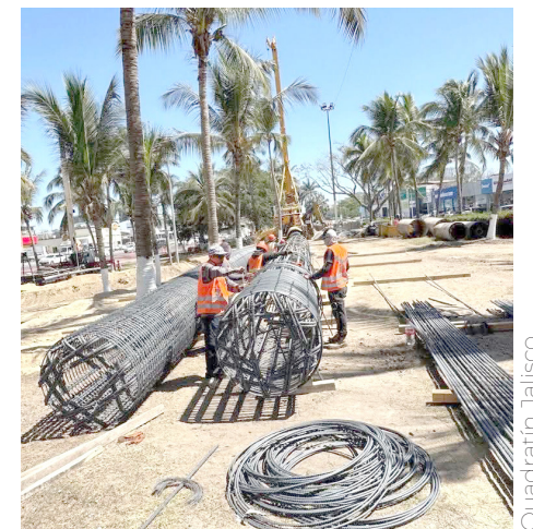
Se trata de un puente vehicular en sentido de Puerto Vallarta hacia Bahía de Banderas.
