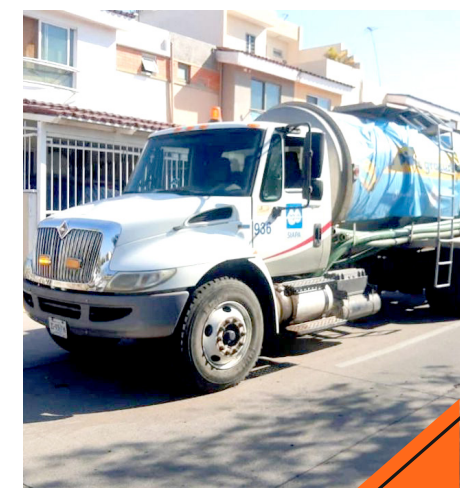
Se realizaron trabajos para los que fue necesario el corte al suministro.
