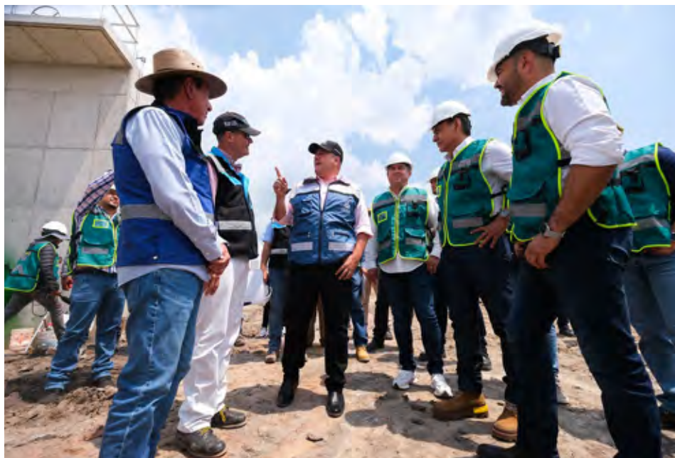
Ya se tiene lista la conexión para el acueducto que va a dotar agua a esta planta potabilizadora.
