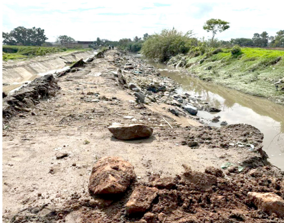
Se realizó la rehabilitación y protección del cauce del Arroyo Seco.
