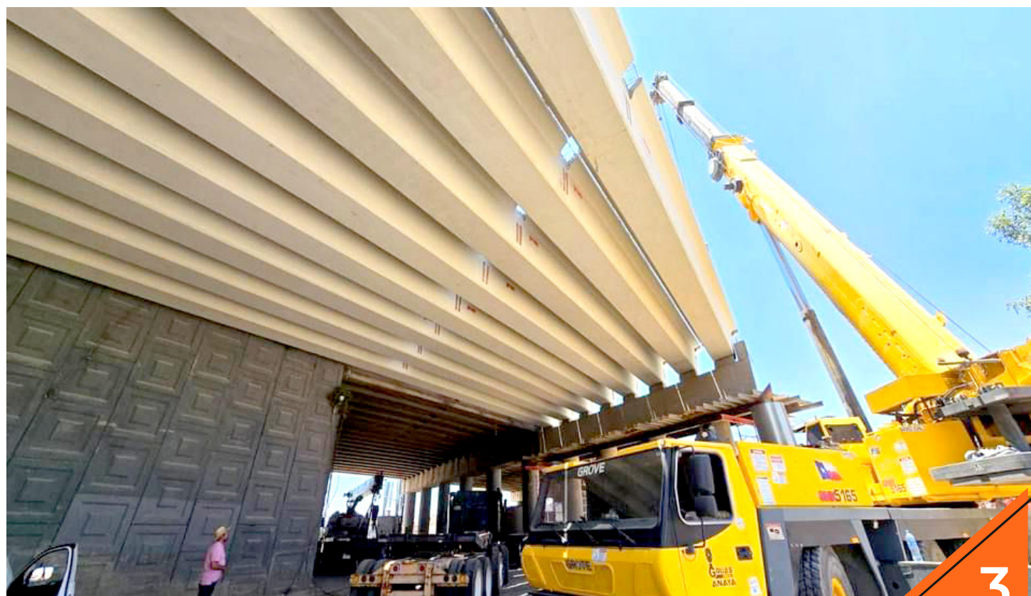
En Periférico sobre el paso a desnivel de las vías ya se colocaron unas trabes.
