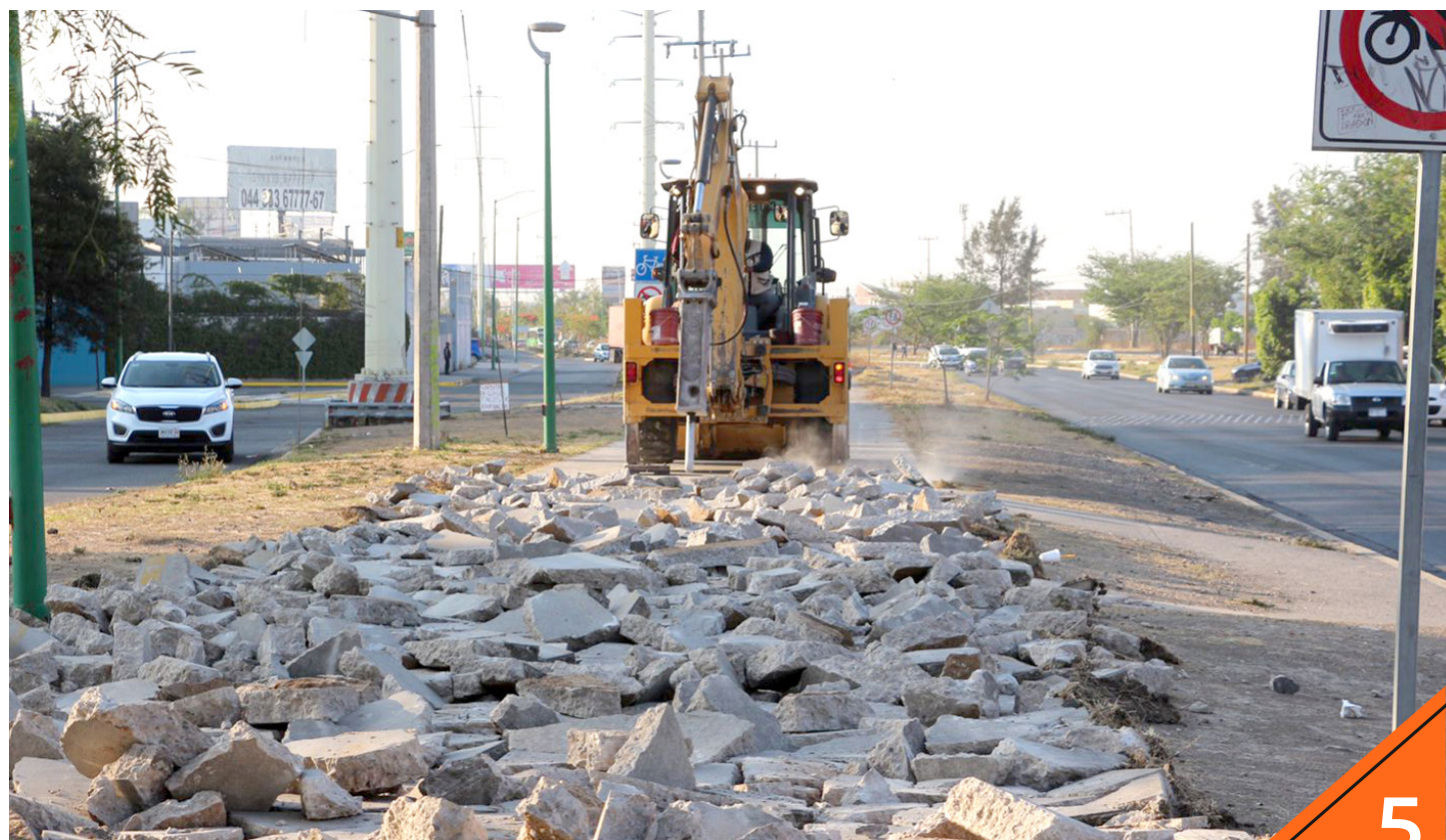
Los trabajos se realizan sobre Adolfo Horn a la altura de las vías del ferrocarril.
